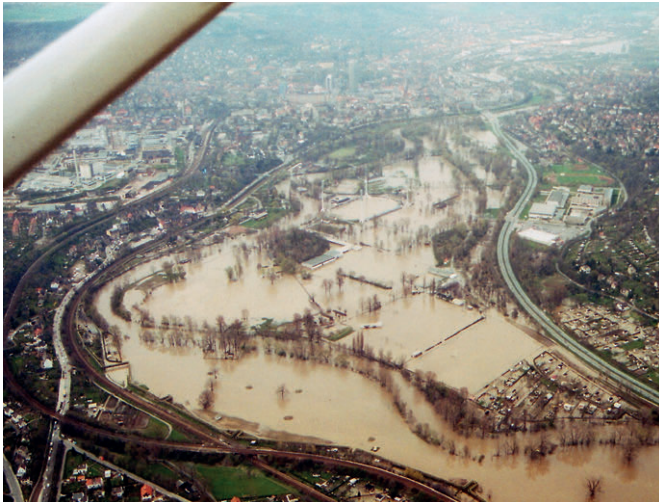
Abbildung 5.4: Auswirkungen des Saalehochwassers im Bereich Oberaue am 14. April 1994 (Quelle: LaNaServ/D. Stremke)
