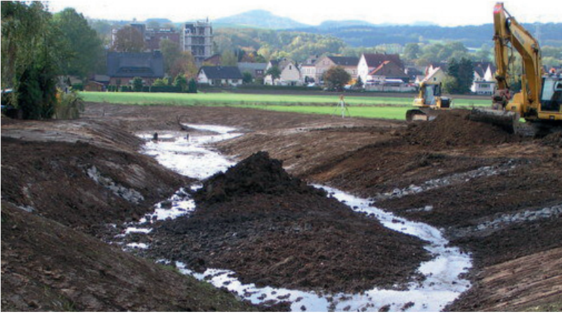
Abbildung 11.11: Aufweitungsarbeiten am Kettlerbach in Arnsberg (Quelle: Stadt Arnsberg 2012)
