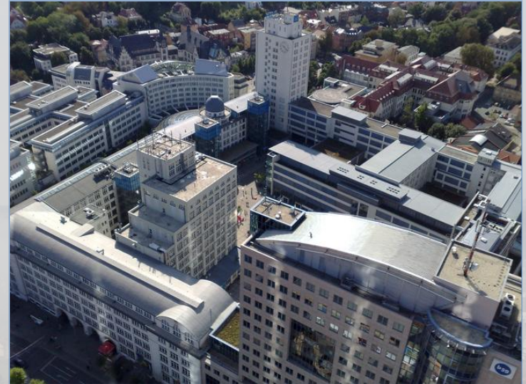
Städtische Oberflächen beeinflussen das Lokalklima (Quelle: Gude 2008)
